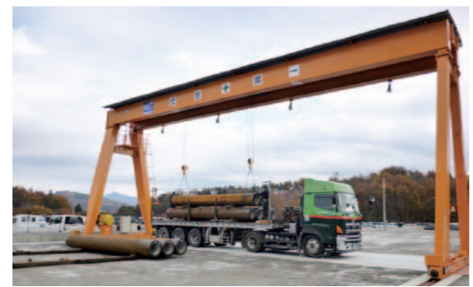
門型クレーン作業風景
