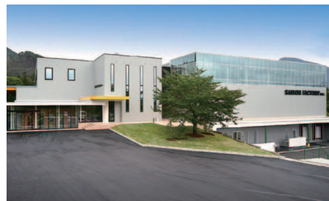
本社工場外観（右側が新工場）
