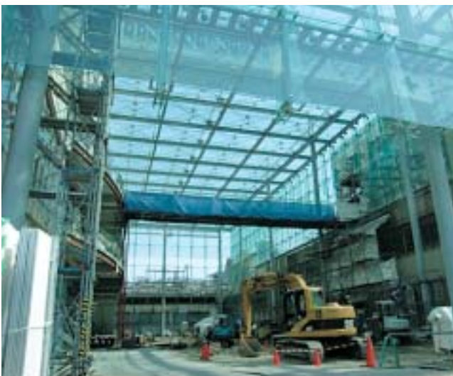
平成19年9月のオープンに向け工事中の賑わい広場(グランドプラザ)
