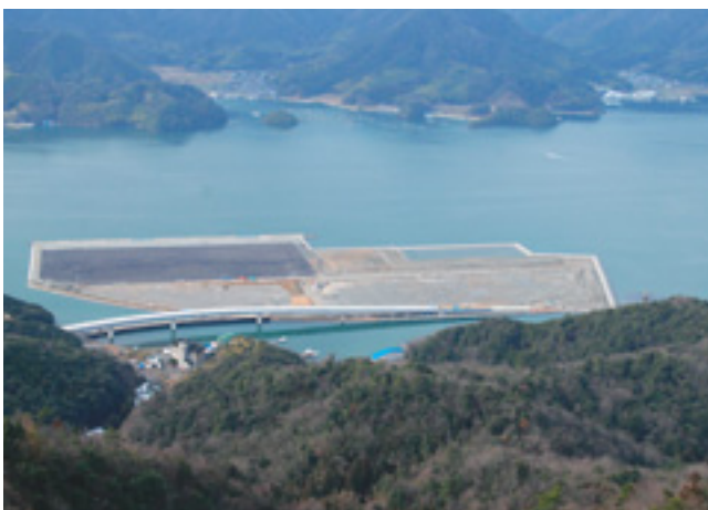
平成22年春の供用開始に向け着々と整備が進む(仮称)和田ふ頭
