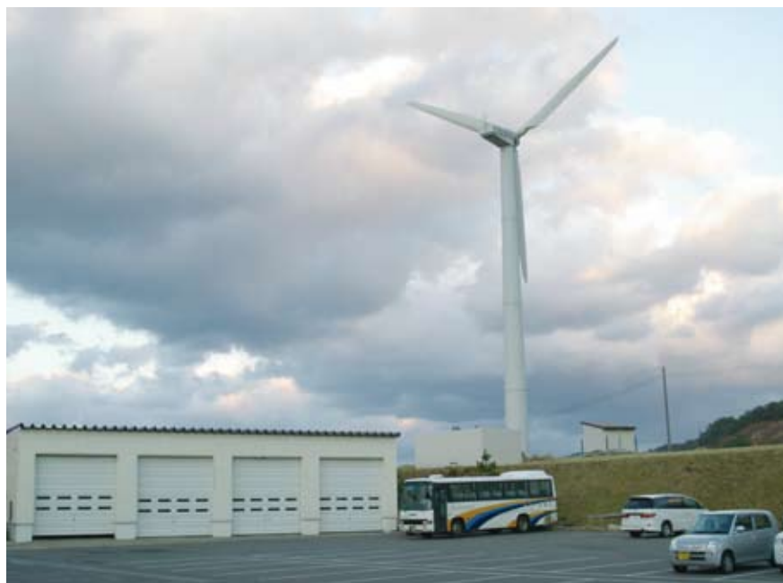
深浦は風がよく吹く。その風を活用した風力発電施設。
