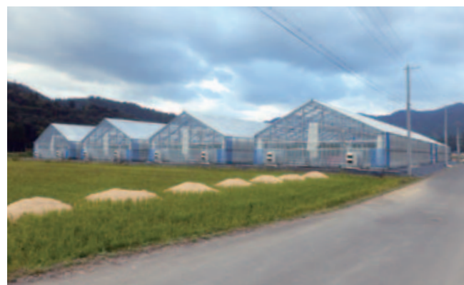
連棟ハウス外観
