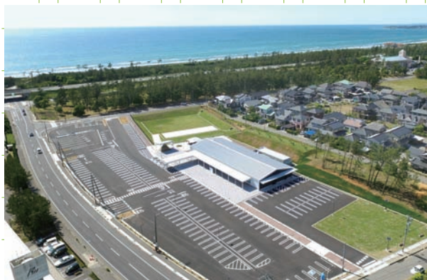
竣工直後の「道の駅のと千里浜」
