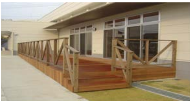
バイオマス抗菌水溶性塗料を施工したウッドデッキ
