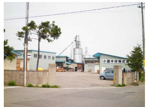
小館木材工場外観
