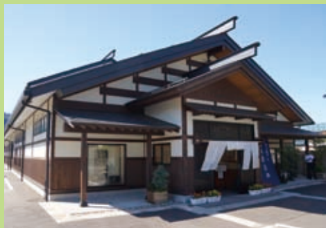
見る、味わう、購入するが集約された佐藤養助総本店。 二階が本社事務所となっている
