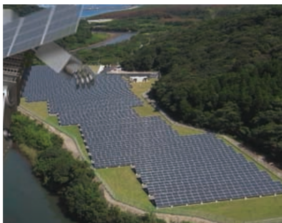
次世代のエネルギーを担う太陽光発電所
