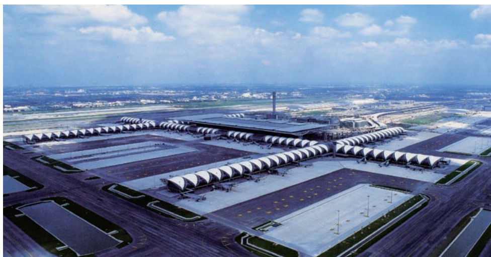
ふつ素樹脂の屋根材はタイのスワンナプーム国際空港にも導入された
