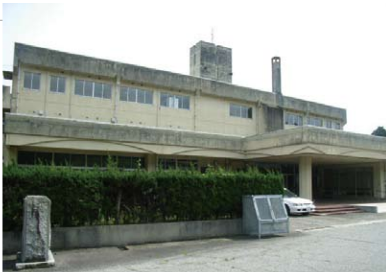
能登町クロマルハナバチ試験飼育・生産施設として改装された旧三波小学校
