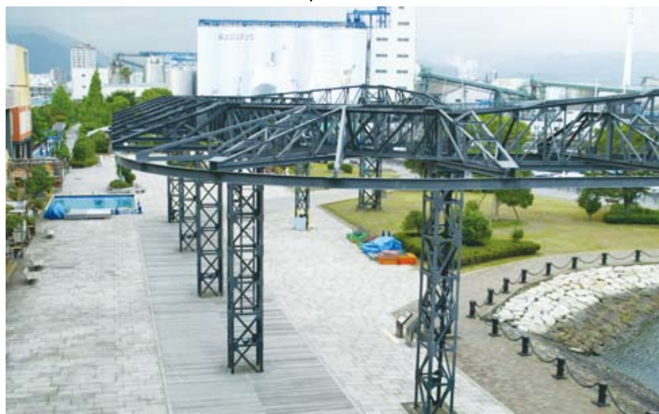
エスパルスドリームプラザの海側デッキには、日の出地区が港の中心であった頃の荷役施設「テルファー」（1928年設置）がモニュメントとして保存されている。
