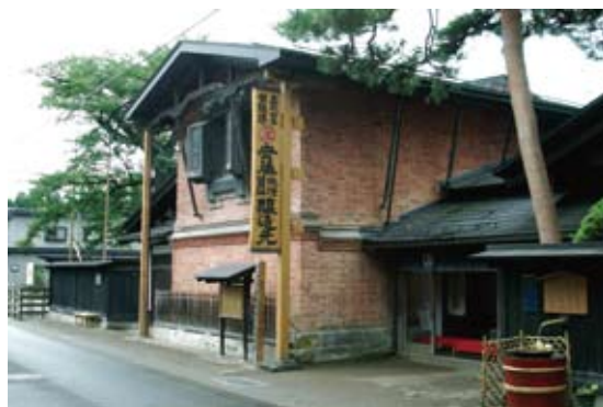
角館の町人町はたびたび大火に見舞われ、安藤家も罹災した。現在の建物は明治15～24年にかけて建てられたもので、火災に備え蔵をレンガ造りにしている。
