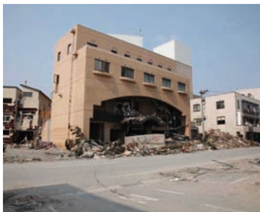
瓦礫でふさがれた正面入口部分 (写真提供：大船渡プラザホテル)
