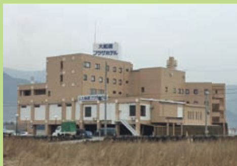
地域にとって復興のシンボルともいうべき 大船渡プラザホテルの外観
