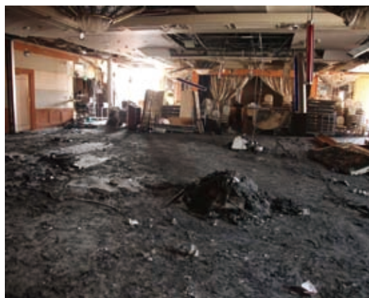
土砂で埋め尽くされたロビー (写真提供：大船渡プラザホテル)
