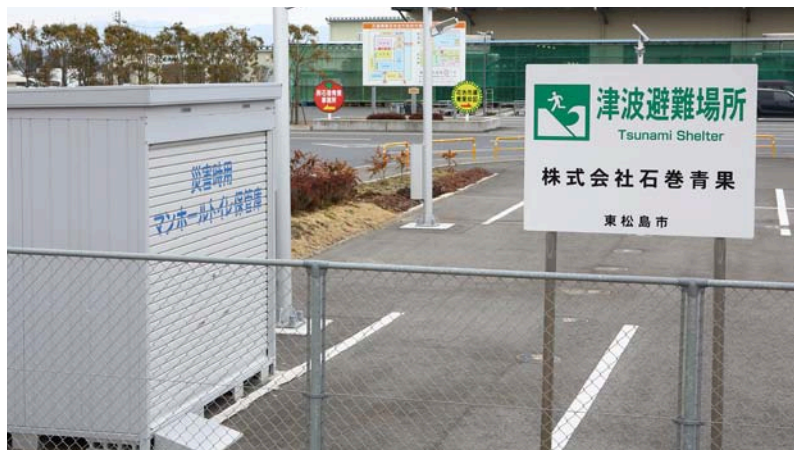
東松島市との災害時支援協力協定に基づき、避難場所に指定されている。マンホールトイレは路面埋設で非常時に組立設置
