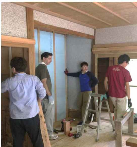
古民家断熱改修ワークショップの様子
