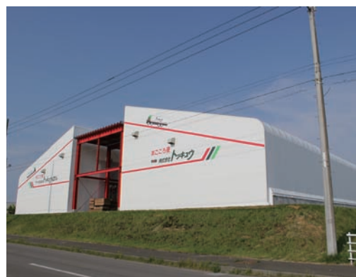
新設したテント倉庫 T・L センター
