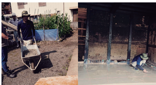
空き家再生作業の様子
