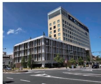
庁舎対象事例：奈良県橿原市庁舎 ホテルを合築した市庁舎の外観 （低層棟が市庁舎）
