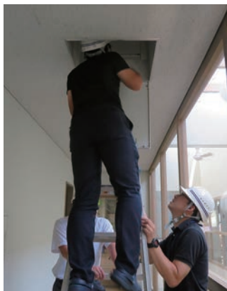
施設の点検風景：専門家の指導を受け職員と一緒に点検
