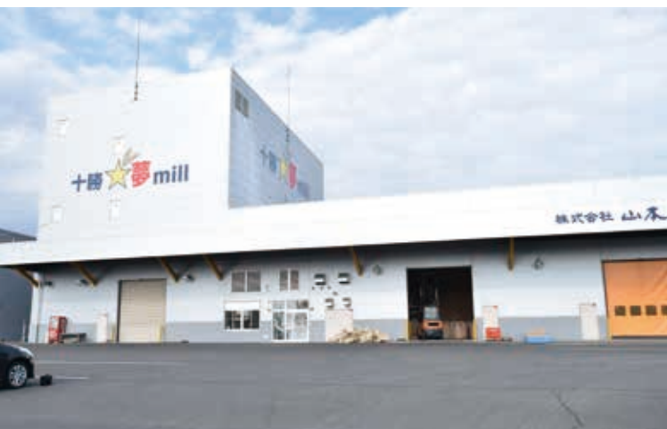
ふるさと融資も活用して建設された十勝初の本格ロール式製粉工場「十勝☆mill」
