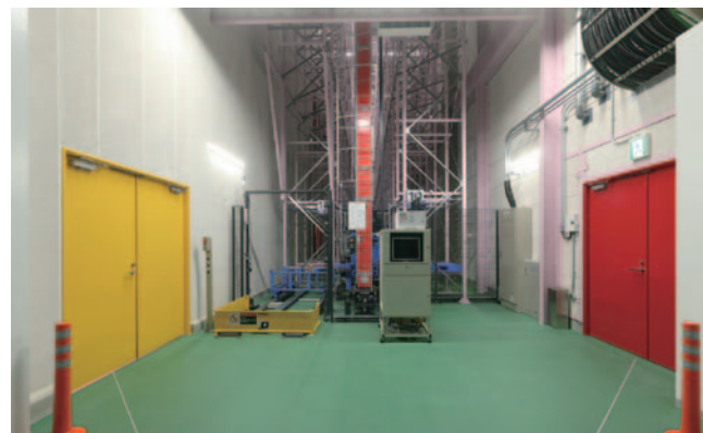
1階 自動ラック倉庫
