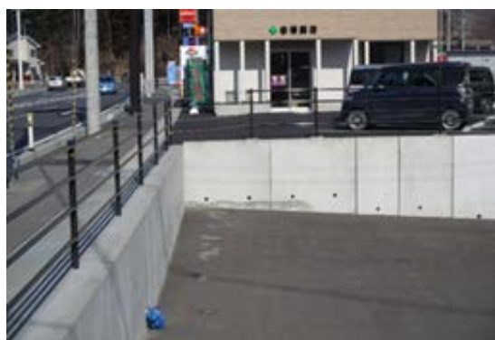
《設置場所（スーパーの駐車場）》
