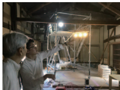
施設改修の様子
