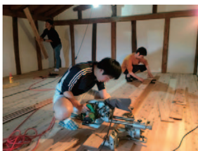
蔵改修の様子
