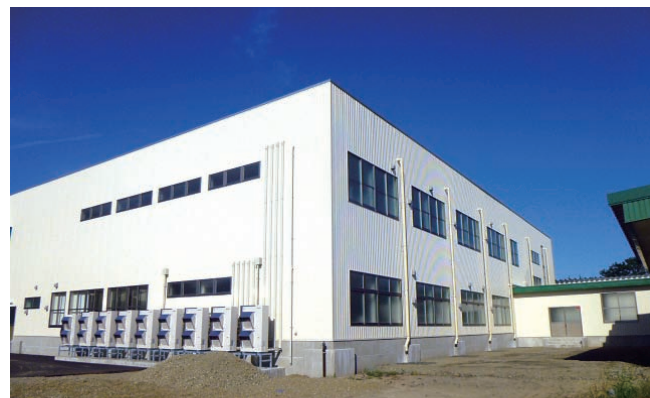
増築部分の外観
