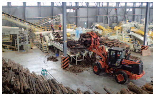
木質チップ製造工場内部
