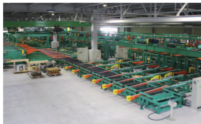
CLT 工場製造棟
