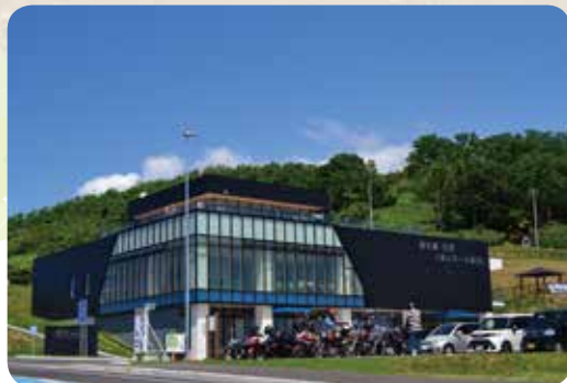
平成30年にオープンした道の駅石狩「あいろんど厚田」
