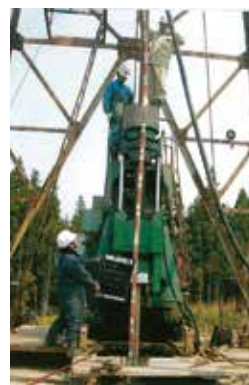
温泉の掘削作業
