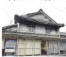
本田酒屋（改修前）
