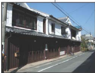
丸林本家 再生した町家3棟は、カフェ、住宅、 木の工房として活用
