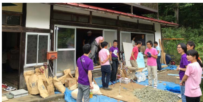
図表 紫波町における古民家の断熱改修WSの様子
