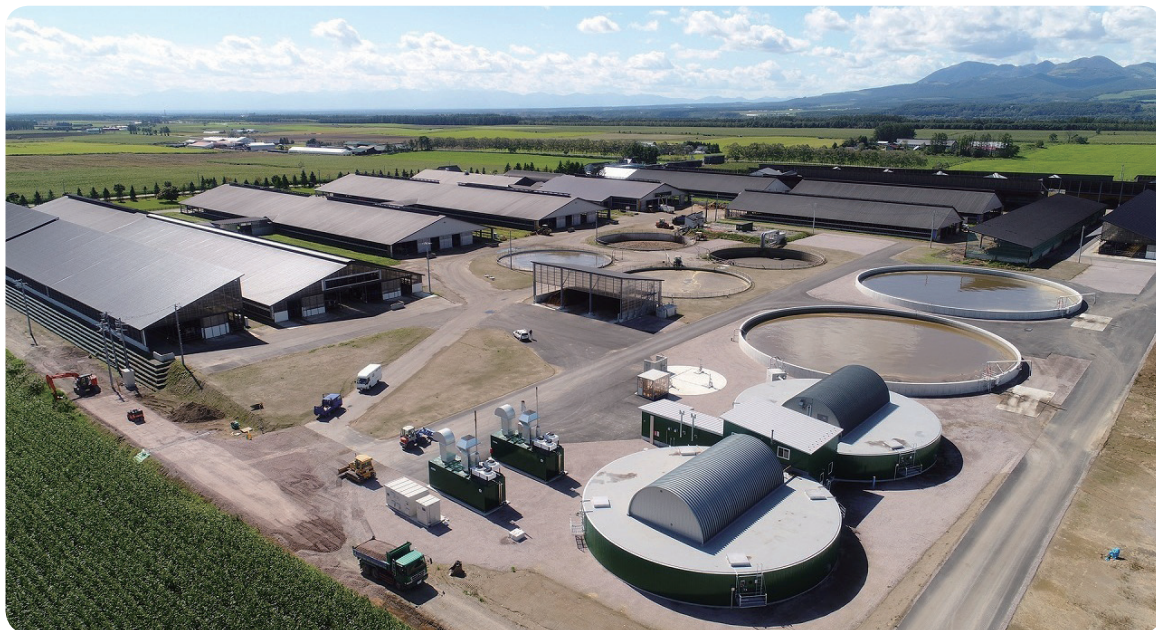
(南)ドリームヒルのバイオガスプラント（北海道上士幌町）
