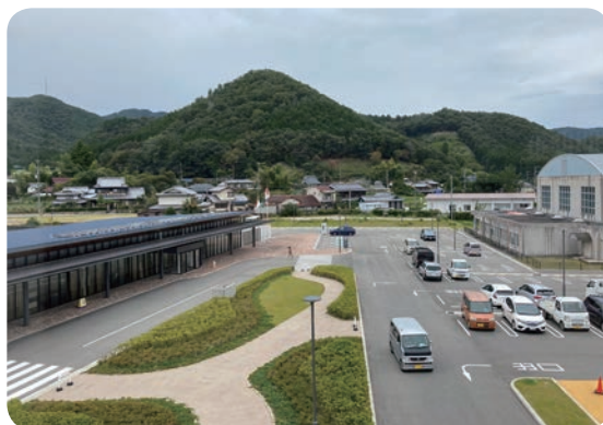
PPA 事業により太陽光パネルが設置されている能勢町庁舎
