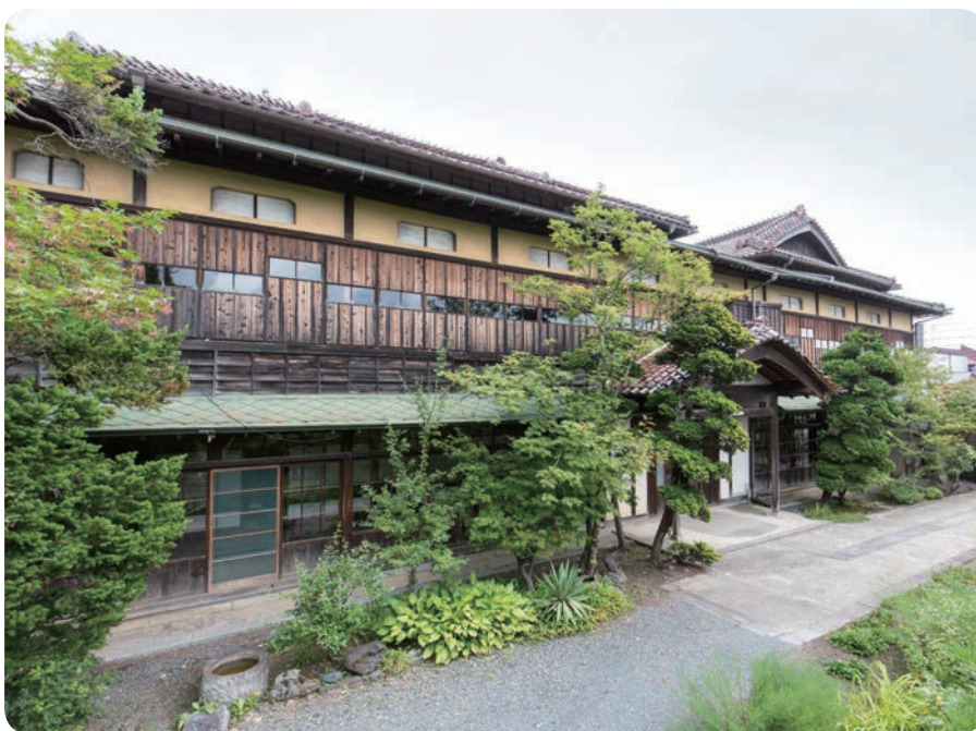
大正10年に完成した日詰平井邸では100年の時を経て醸造所を復活させるプロジェクトが始動しています
