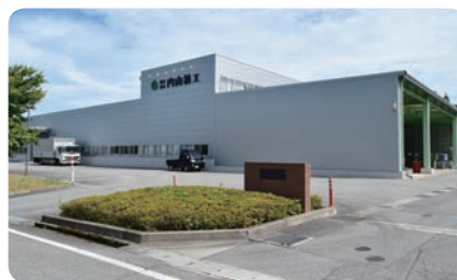
第3工場全景。第1、第2工場では手狭になり、増設された
