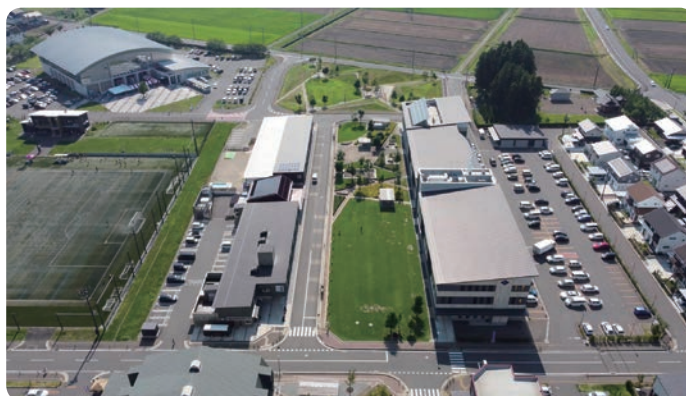
オガールプロジェクトの中核施設全景。公民複合施設「オガールプラザ」、民間複合施設「オガールセンター」、「オガールベース」が建ち並ぶ
