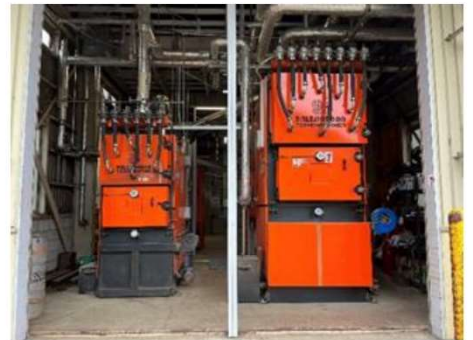
木質バイオマスボイラー 出典：ヒアリング時撮影
