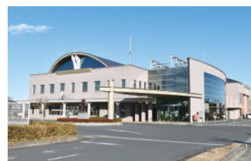
公共施設等管理計画に基づき複合化された高萩市総合福祉センター
