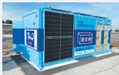
「国土交通省 栃木県「道の駅しもつけ」防災用コンテナ型トイレ」 画像提供：一般財団法人日本みち研究所
