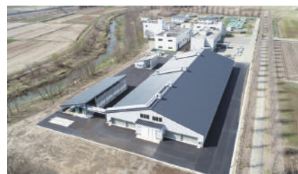
DBO方式*により整備された秋田県県南地区 広域汚泥資源化施設
